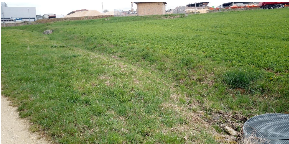
Abb. 10: Entwässerungsgraben im Südosten des Plangebiets.
