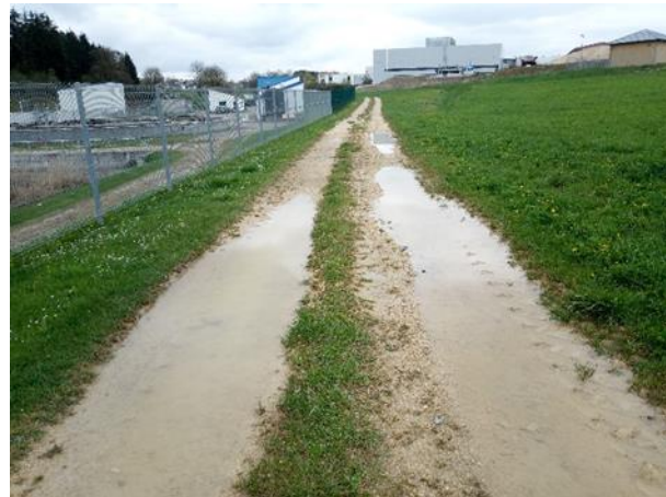
H: Feldweg mit wassergefüllten Fahrspuren neben der Kläranlage
